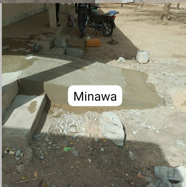
Differents images et étapes de constructions d'une rampe d'accès à l'école primaire de Minawa dans le Diamaré.
