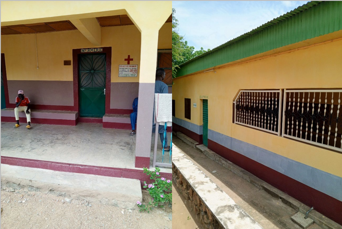
A gauche l'infirmerie après réfection, à droite façade latérale du centre de rééducation après réfection
