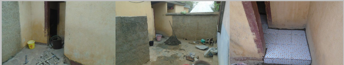
Toilette Saré réhabilité
